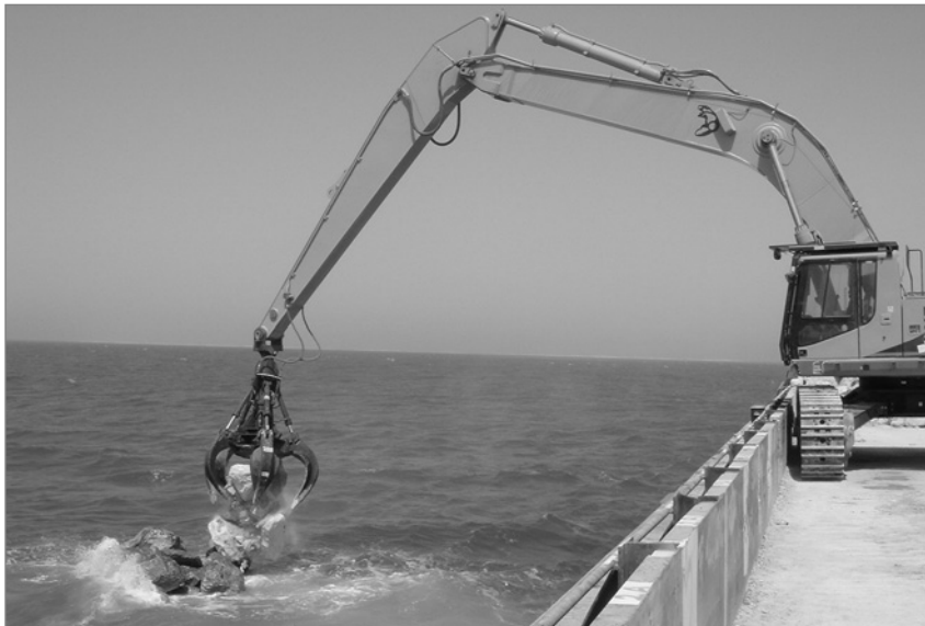
Figure 9.22 Pose d'enrochement avec une pelle (source : Van Oord)
