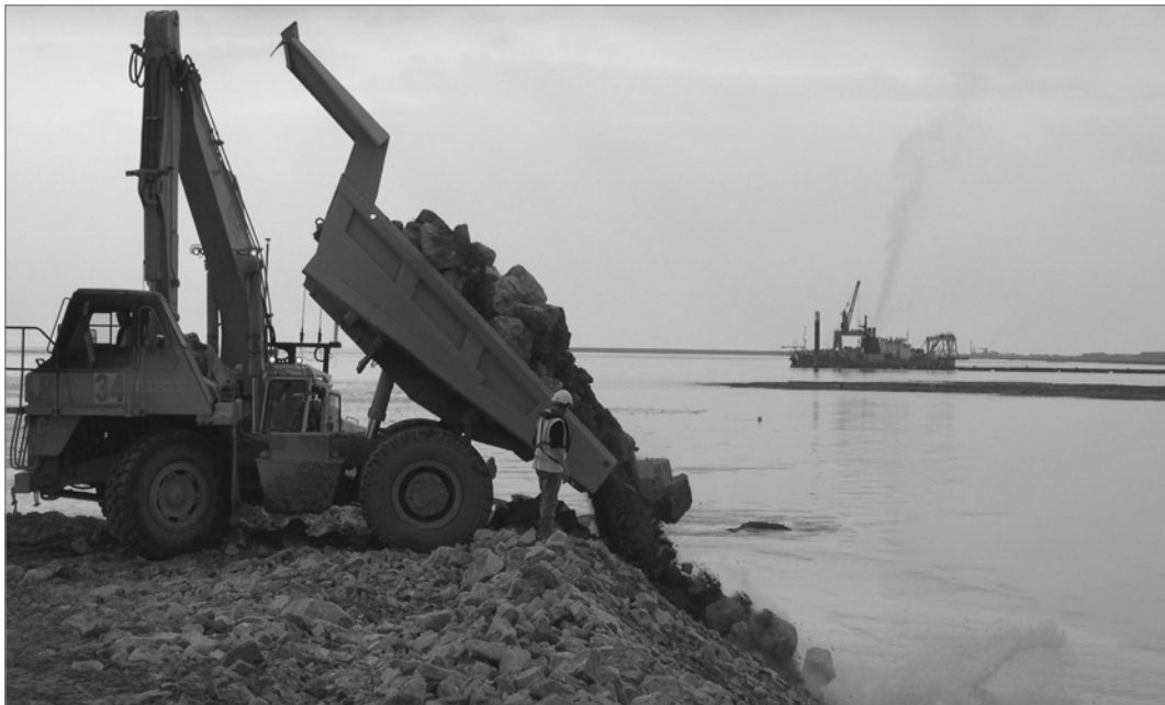
Figure 9.36 Exemple d'un tombereau transportant des enrochements de la zone de stockage temporaire à la section de digue en construction (source : Port Autonome du Havre)
