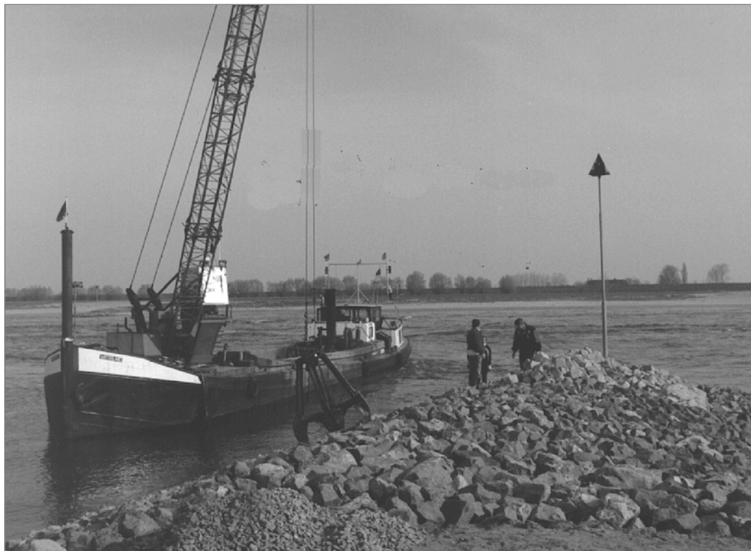
Figure 9.68 Pose et réglage d'une couverture d'épi (source : Van Oord)
