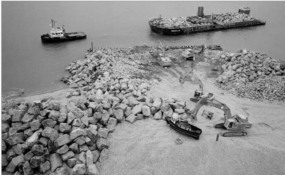
Figure 9.11 Déchargement d'une barge de transport maritime (source : Royal Boskalis Westminster)
