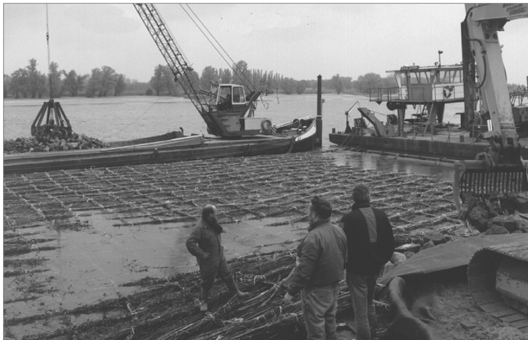
Figure 9.67 Matelas de fascines en position, début du lestage (source : Van Oord)
