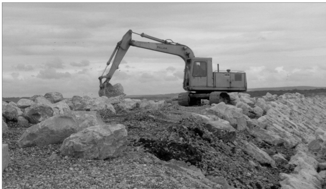
Figure 9.14 Pelle (à caisse renforcée) travaillant depuis la crête (source : J D Simm)
