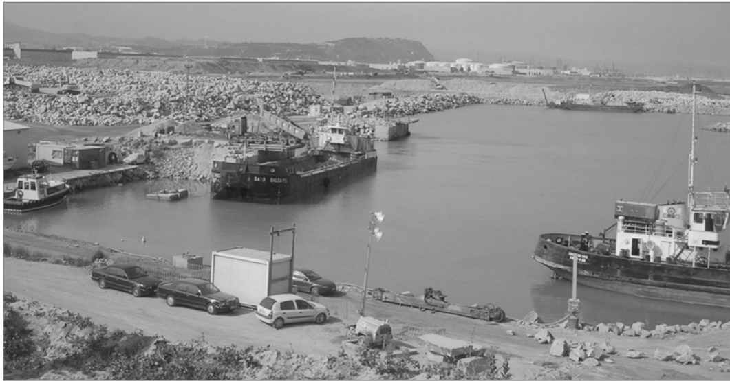
Figure 9.34 Vue d'ensemble de la zone de stockage du chantier de Barcelone où les camions livrent des enrochements ou chargent les barges pour déversement sur le chantier (source : CETE de Lyon)
