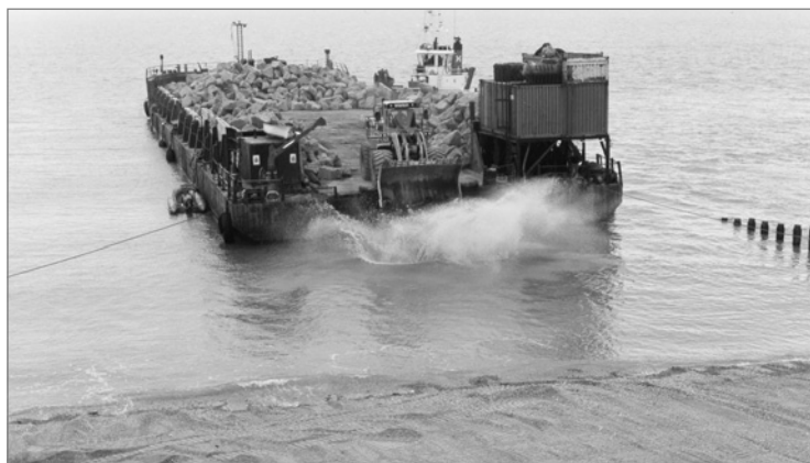
Figure 9.13 Chargeuse sur pneus embarquée sur une barge échouée (source : Royal Boskalis Westminster)
