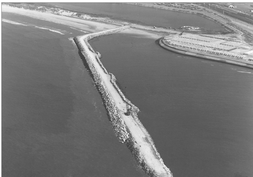
Figure 9.55 Pose d'une carapace, montrant les élargissements permettant aux engins de tourner et de se croiser sur la crête du noyau (source : Van Oord)
