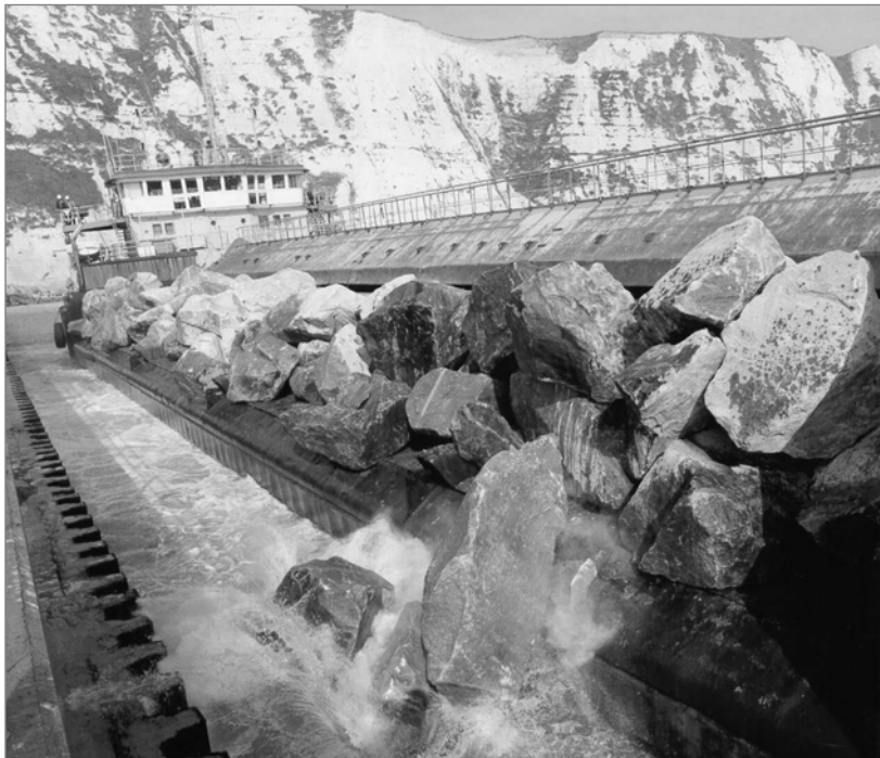
Figure 9.21 Navire à déversement latéral Cetus déversant de l'enrochement 1 à 3 t près d'une jetée (source : Royal Boskalis Westminster)
