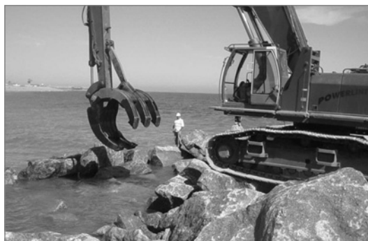
Figure 9.17 Exemples de grappins utilisés pour la pose de blocs d'encrochement
