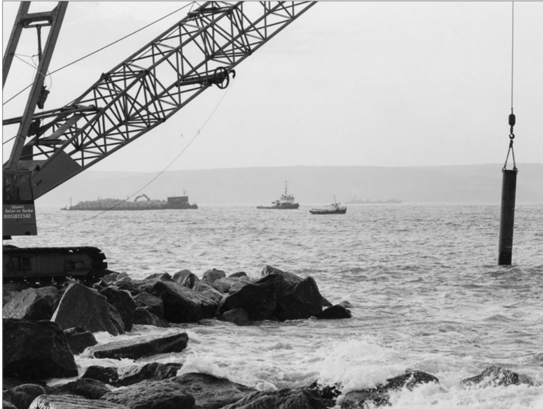
Figure 9.70 Vérifications des profils sous-marins avec une barre de sondage (source : David Bowie)
