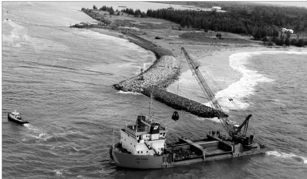
Figure 9.23 Grue montée sur le navire Jan Steen, approvisionneur de blocs d'enrochement (source: Van Oord)
