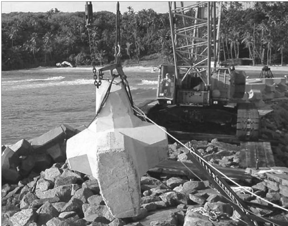
Figure 9.61 Utilisation d'un crochet à ouverture rapide (source : Interbeton)
