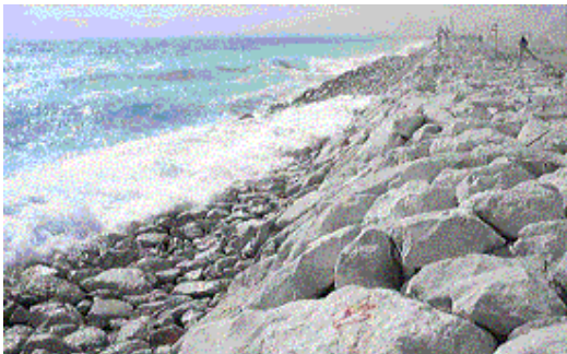
Fig 11 : Assaluyeh berm shore protection
